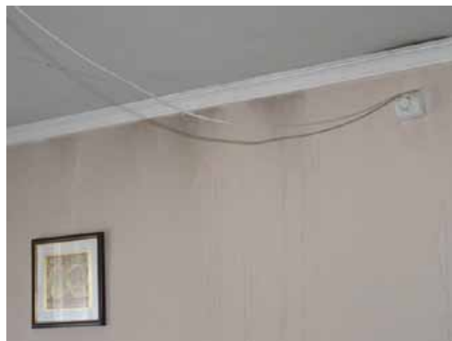
5. ÁBRA: FÜSTTERJEDÉSI NYOMOK A TŰZMENTETT OLDALON (FOTÓ: DR. TAKÁCS LAJOS GÁBOR)
