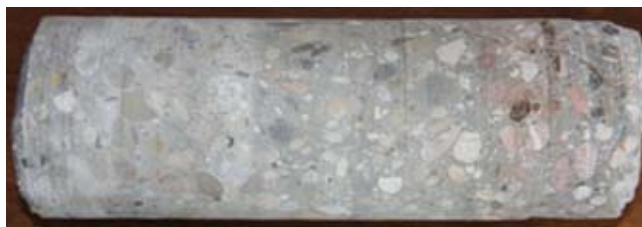
9. ábra. A tűzkárosult szerkezetből vett furatmagminta
