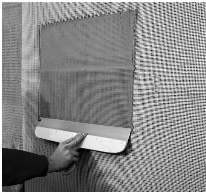
2. ábra. Vakolása a polisztirol habos rendszerekkel azonos módon történik
