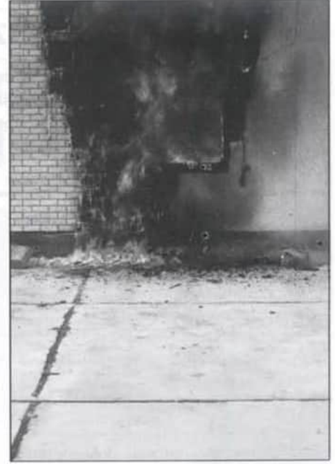
15-16. perc: lehulló, égő burkolat meggyújtja a tűztér alatti burkolatot is
