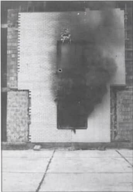
A propipropilén burkolat a hő hatására a felső nyílászáró felett is megolvadt
