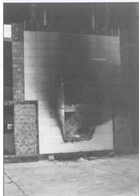
25. perc: a tűzhattás mérséklődik, a homlokzat nem károsodik tovább
