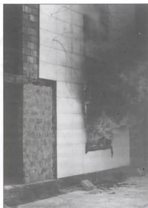
A nyílászárók közötti burkolat önállóan ég (18. perc)
