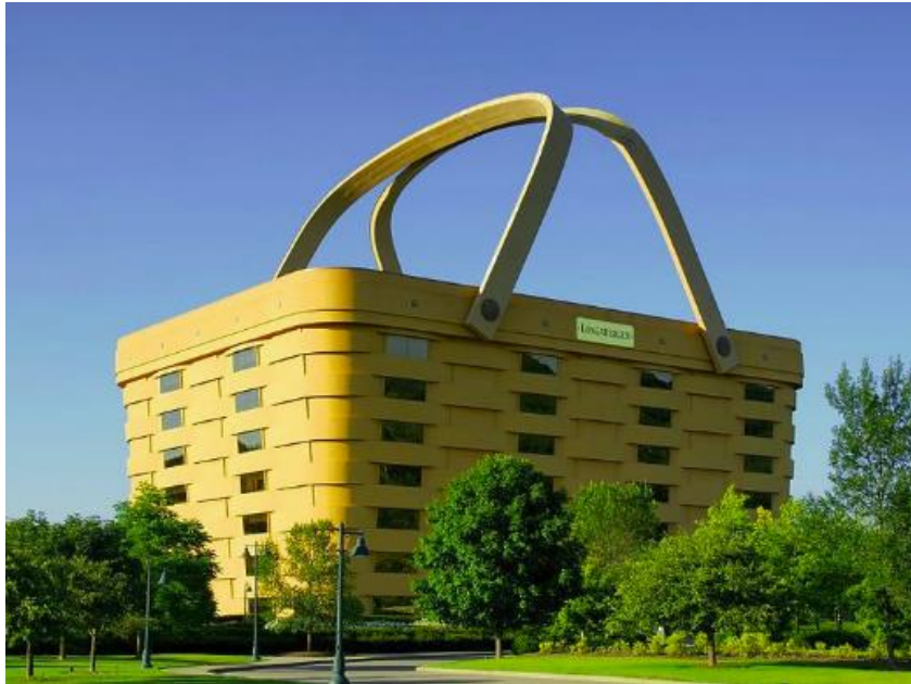
Longaberger kosárgyártó cég 1997-ben épült központi irodaépülete
