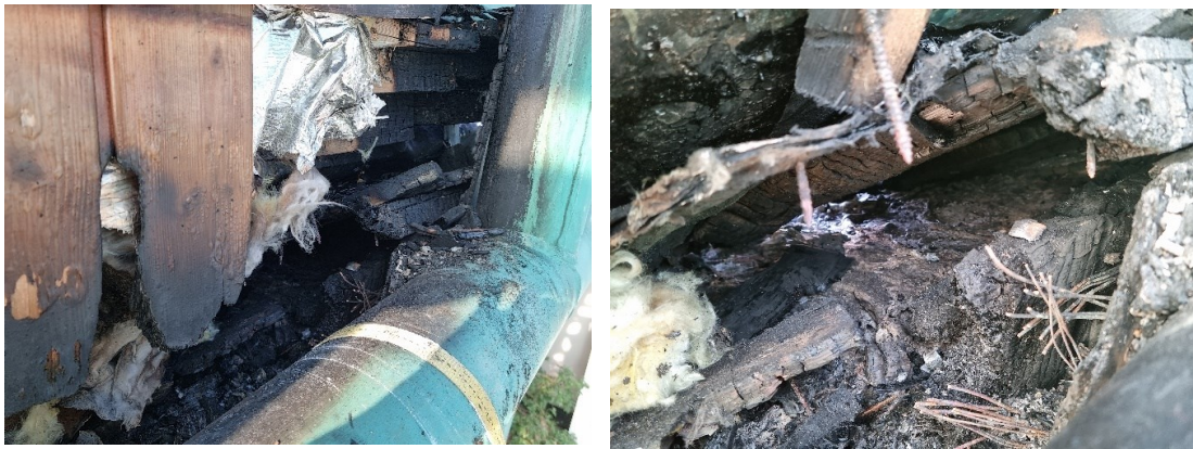
12. ábra: Helytelenül kialakított szerkezeti csomópont
