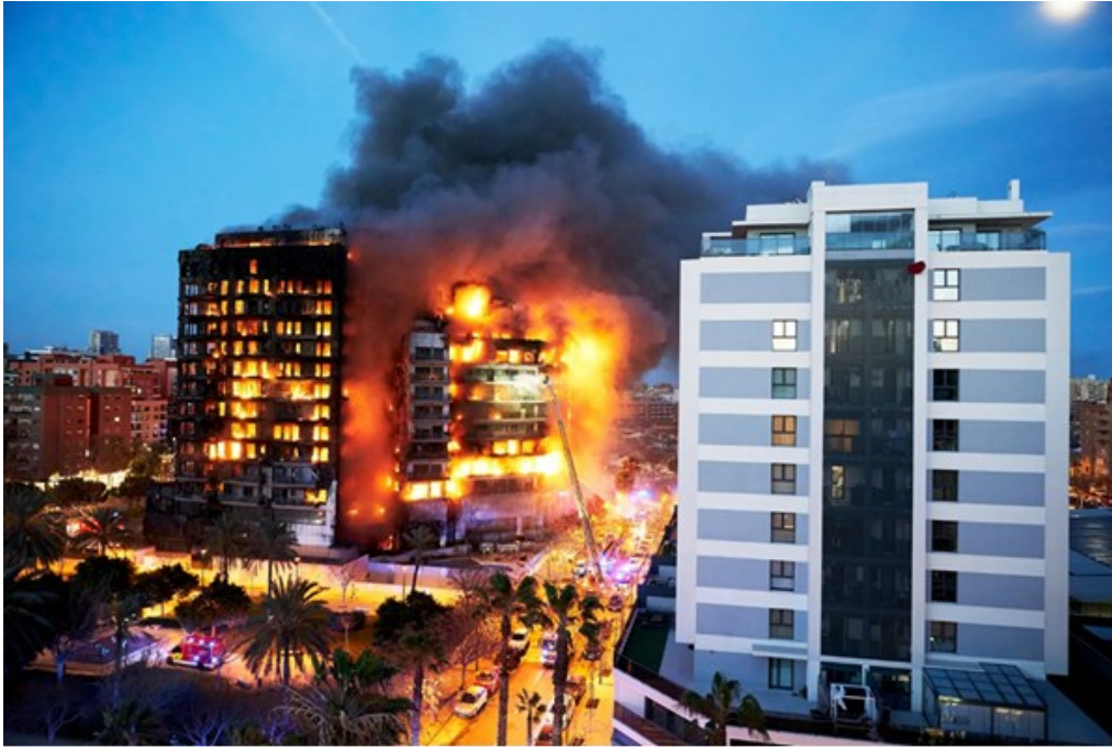
5. ábra: Valenciái lakóépület tűz 2024. február 22.
