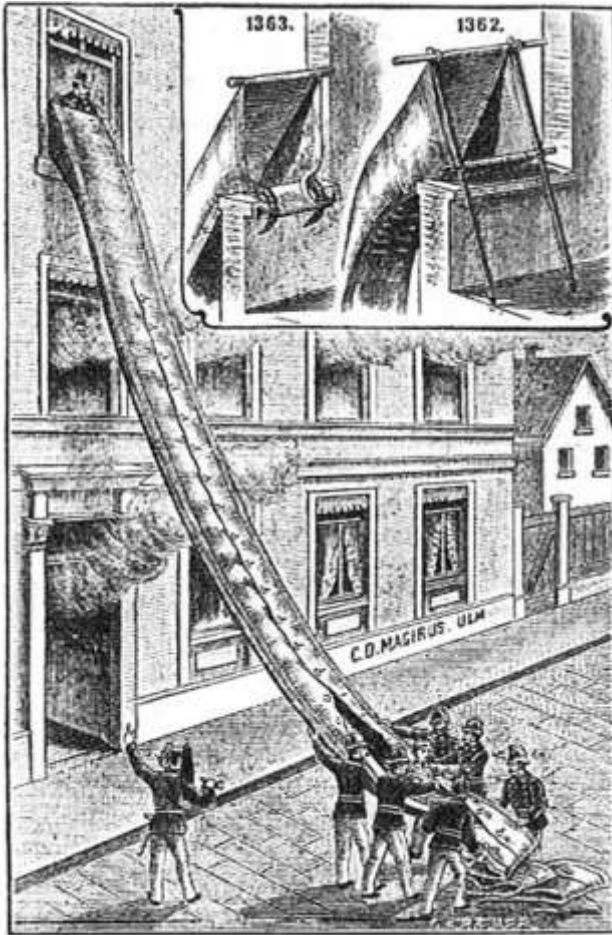
11. ábra: A mentőtömlő használatra készen. Jobb felső sarokban a rögzítési módok. Érdeemes megfigyelni, hogy a feljutás problematikáját diszkrétan kifejejtették, ugyanis nincs horoglétra az ablakokban. 10
