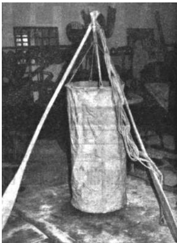
35. ábra: Igazi ritkaságszámba menő fennmaradt mentőzsák, a lendvai tűzoltó kiállításról. A cikk külön megjegyzi, hogy a zsák vízzállításra is alkalmas volt. Csakúgy, mint a bádóg előtti viaszkos vászon vödrök. 32
