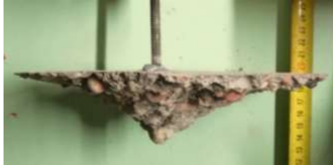
10. ábra. – Kúpszerű kiszakadás tűzkárosodott betonban
