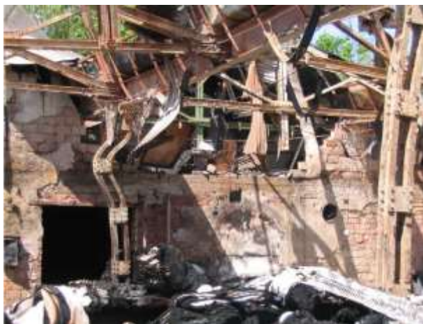
15. ábra Tűzfal stabilitás vesztese és leomlása
