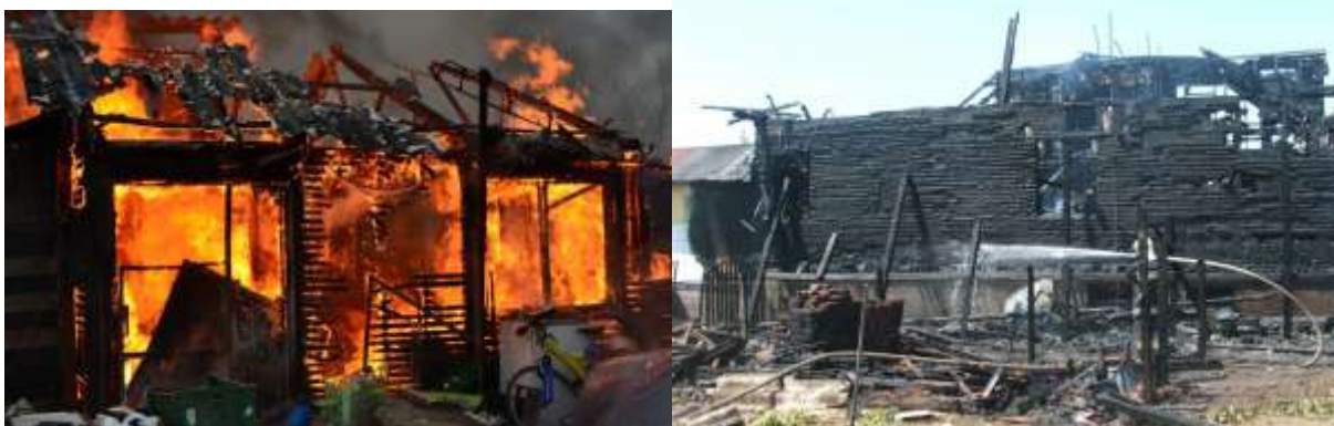
10. ábra Könnyűszerkezetes épület, faház tüzesete
