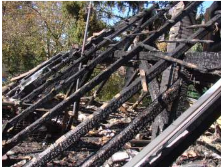
12. ábra Beégés nyomok mélységének változása a szarufákon
