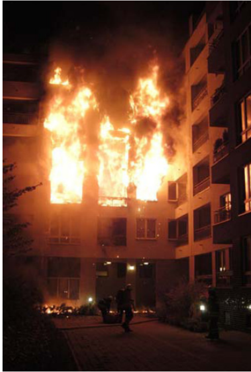
13. ábra Tűzátterjedés homlokzaton
