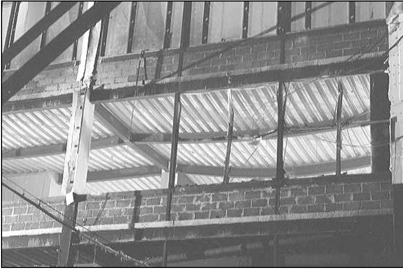
12. ábra Alakváltozott szerkezet a tűz folyamán
