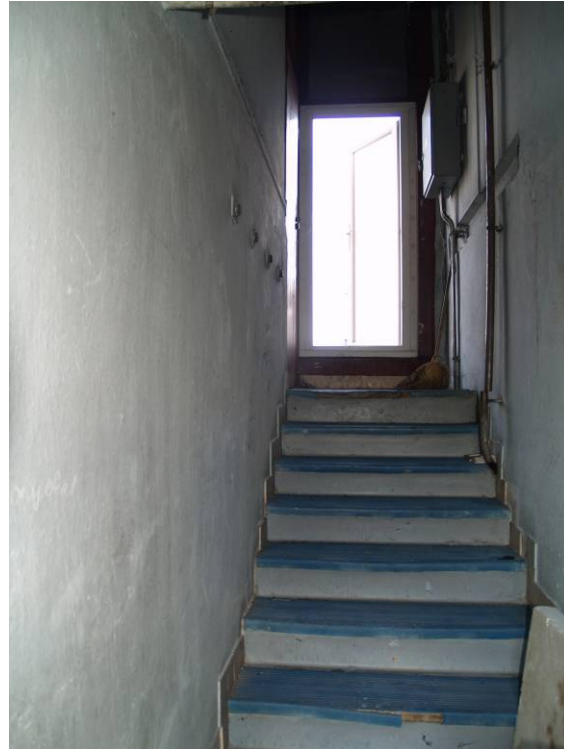
21 sz. kép. A lépcsőház tetőkijárata (fotó: Takács Lajos)
