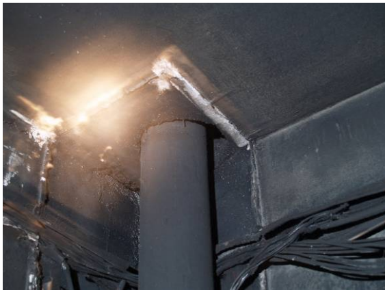
8-9 sz. képek. Az előszobai csapadékvíz ejtővezeték felső (balra) és alsó (jobbra) földemcsatlakozása a VII. emeleti lakásban. Jól látható, hogy a földemek vonalában semmilyen tűzterjedést gátló tömítés vagy kitöltés nem készült. A jobboldali képen látható az ejtővezeték faforgácslapból készült burkolata (fotó: Takács Lajos)
