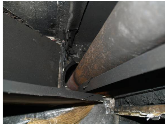
8-9 sz. képek. Az előszobai csapadékvíz ejtővezeték felső (balra) és alsó (jobbra) földemcsatlakozása a VII. emeleti lakásban. Jól látható, hogy a földemek vonalában semmilyen tűzterjedést gátló tömítés vagy kitöltés nem készült. A jobboldali képen látható az ejtővezeték faforgácslapból készült burkolata (fotó: Takács Lajos)
