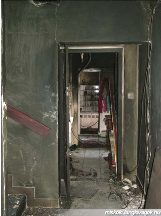
20 sz. kép. A lépcsőház képe a VIII. emeleten. Jól látható, hogy a padlóig megtöltötte a füst (fotó: Miskolci Tűzoltóság)
