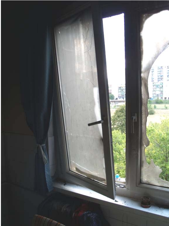
16-17 sz. képek. A VII. emeleti lakás konyhai ablaka és annak zárszerkezete a tűz után. Jól látható, hogy az ablak a tűz idején bukó állásban volt és a kilincset később állították vízszintes helyzetbe (fotó: Takács Lajos – Király András)
