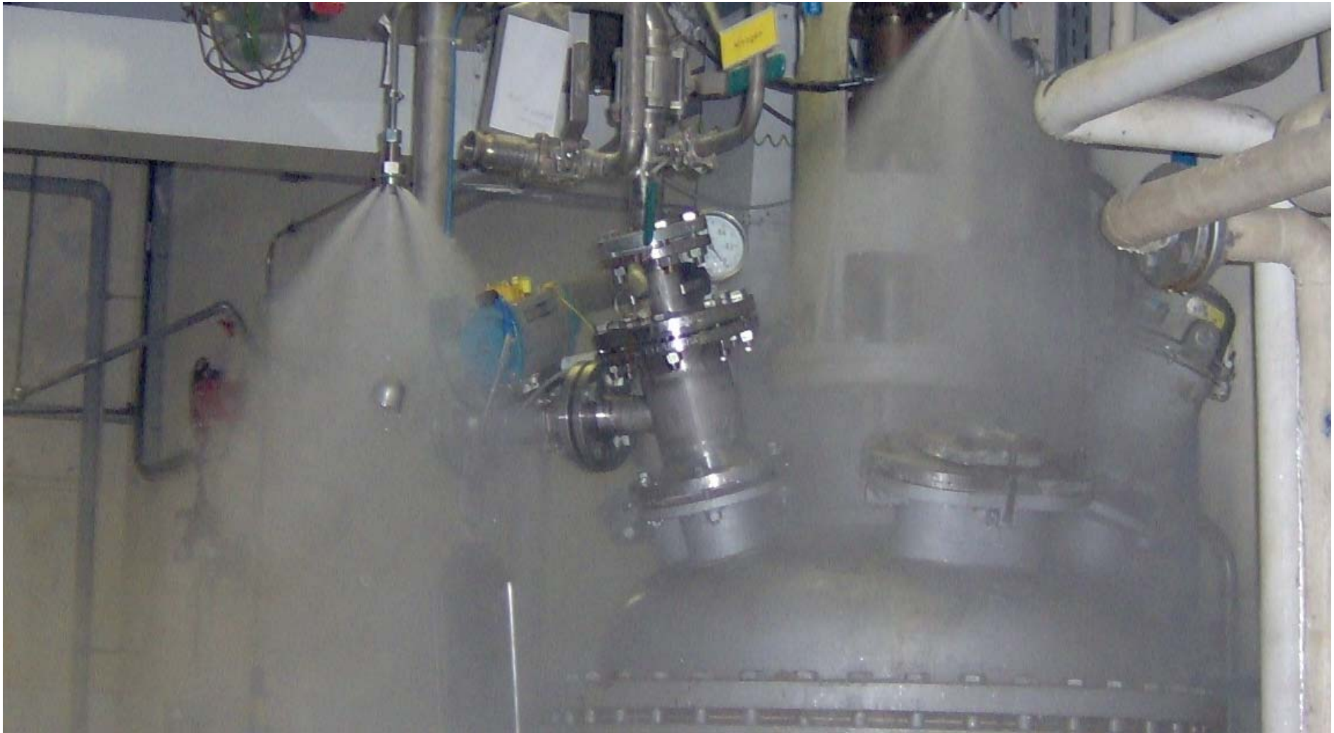
Nagynyomású vízködös oltórendszerek
