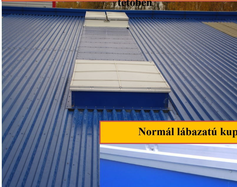
Normál lábazatú kupola kemény héjalású tetőben
