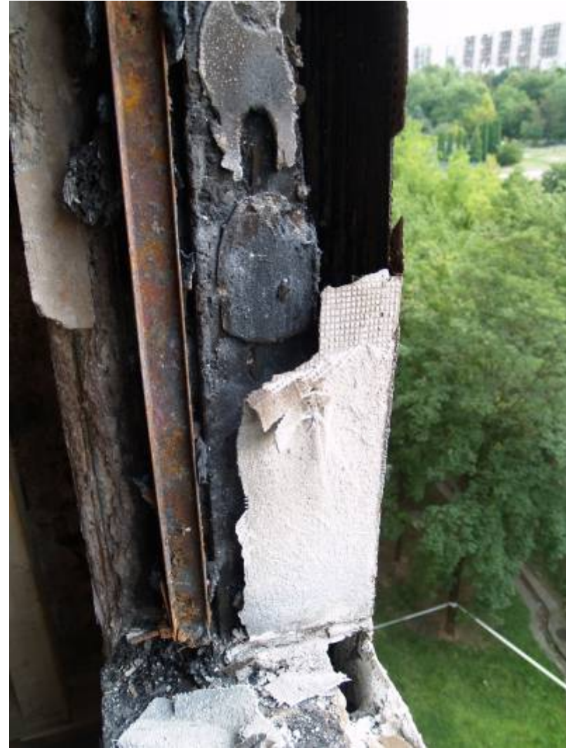
A hőszigetelő táblák szakszerűtlen rögzítése, hibás kávaképzés
