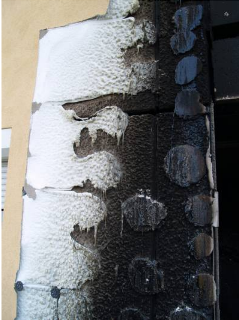
A hőszigetelő táblák szakszerűtlen rögzítése, hibás kávaképzés
