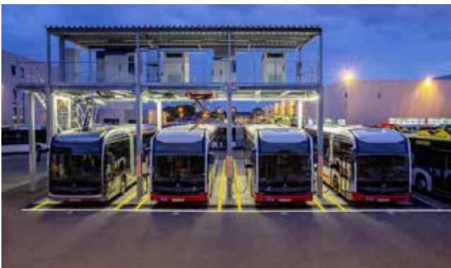
TÖLTŐÁLLOMÁS, BALRÓL JOBBRA: ÁRAMSZEDŐ, PANTOGRÁF, VEZETÉKES TÖLTŐÁLLOMÁSOK
