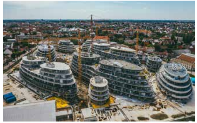
...ÉS EGY JELENLEGI ÉPÍTÉSI ÁLLAPOTRÓL
