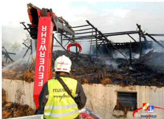
VESZÉLYESSÉ VÁLT TETŐSZERKEZETEK BONTÁSA DARUVAL
