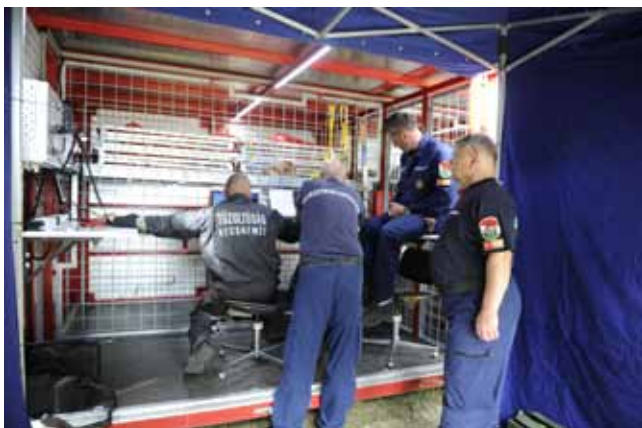
IRÁNYÍTÁSI PONT BEÜZEMELÉSE
