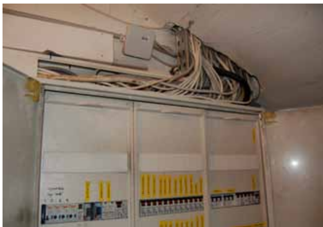
AZ ELHELYEZÉSI PROBLÉMA KÖVETKEZMÉNYEKÉNT ZSÚFOLT ÉS SZAKSZERŰTLENŰ KIALAKÍTOTT VEZETÉKRENDSZER POTENCIÁLIS FORRÁSA A TŰZ KELETKEZÉSÉNEK
