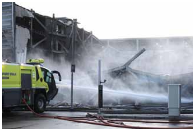
A PARKOLÓHÁZ VASBETON SZERKEZETE SEM BÍRTA
