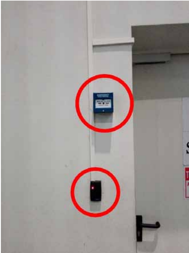
ÉRINTŐKÁRTYÁVAL NYITHATÓ MÁGNESEL RÖGZÍTETT AJTÓ VÉSZNYITÓ NYOMÓGOMBBAL [4]
