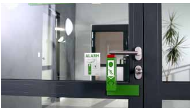
RIASZTÓVAL FELSZERELT MSZ EN 179 SZERINTI VÉSZKIJÁRATI ZÁR [15]
