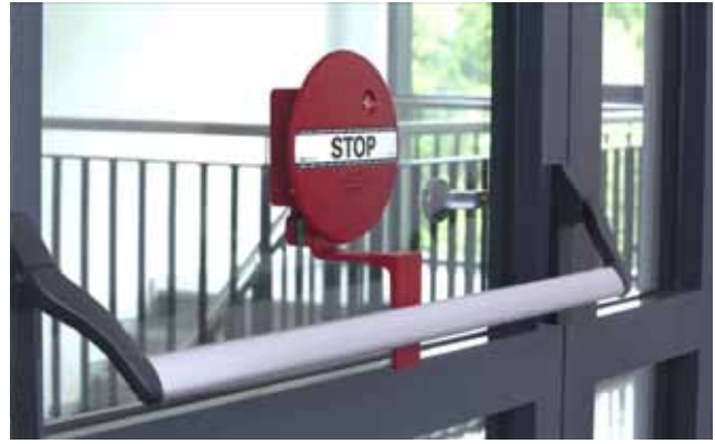
RIASZTÓVAL FELSZERELT MSZ EN 1125 SZERINTI PÁNIKRUDAS VÉSZKIJÁRAT [16]
