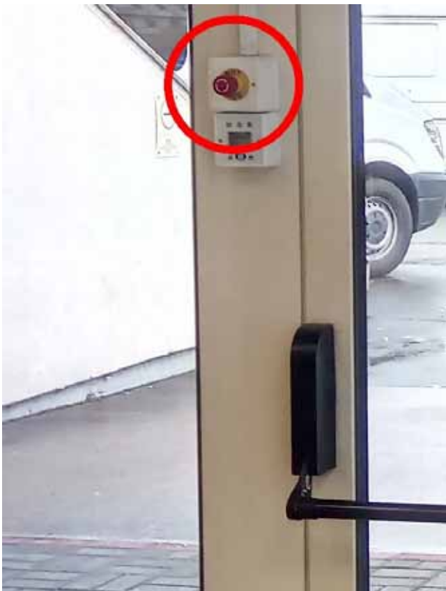
ELEKTROMOS MOTORRAL RÖGZÍTETT VÉSZKIJÁRAT PÁNÍKRÚDDAL ÉS VÉSZNYITÓ NYOMÓGOMBBAL [4]
