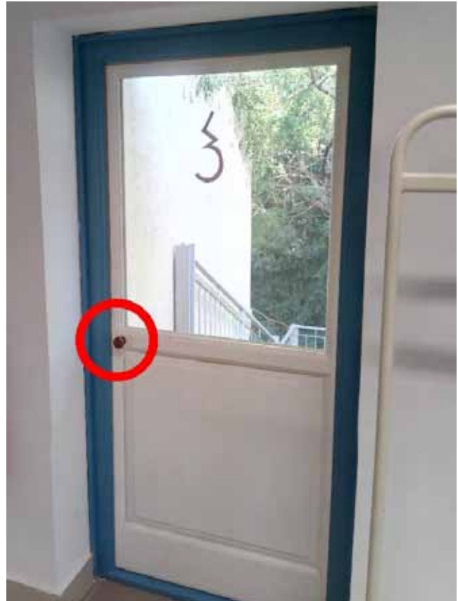
MÁGNESEL RÖGZÍTETT VÉSZKIJÁRAT FOGANTYÚVAL, NYITÓGOMB NÉLKÜL, TŰZJELZÉSRE NYÍLIK [4]
