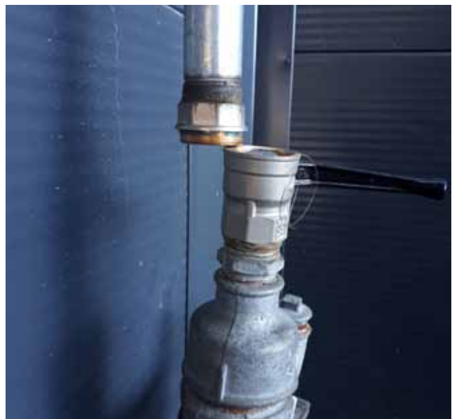
FAGYKÁR SZÁRAZ SPRINKLERRENDSZERBEN
