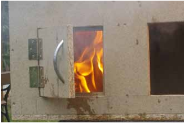
BELOBBAN AZ ÉGHETŐ GÁZ A TÁVOLI ÉPÜLETRÉSZEN
