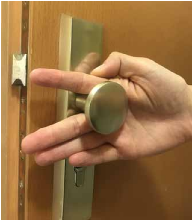
CSAPDA HELYÉNEK MEGHATÁROZÁSA
