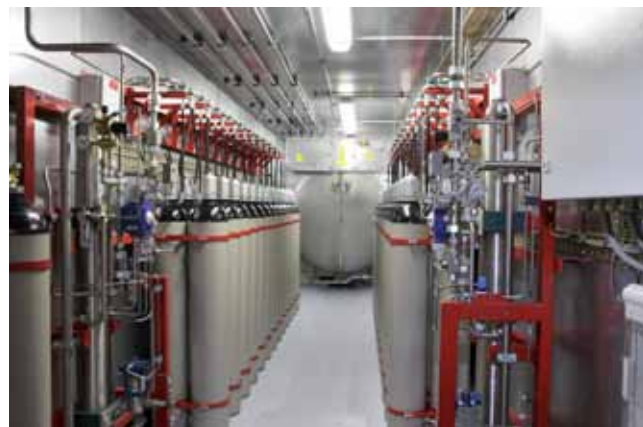
TELEPÍTETT OLTÓKONTÉNER
