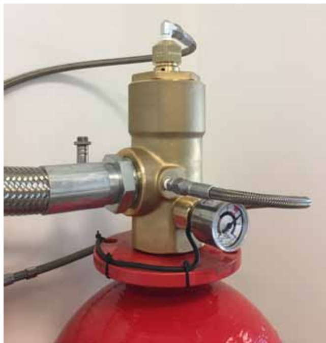
TELEPÍTETT, RÖGZÍTETT OLTÓPALACK
