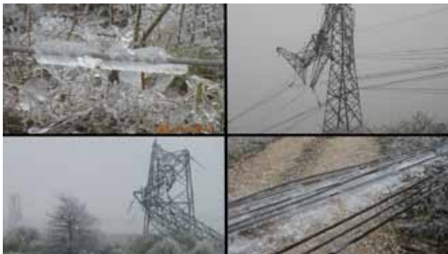
9. ÁBRA: AZ ÓNOS ESŐ OKOZTA JÉGLERAKÓDÁS
