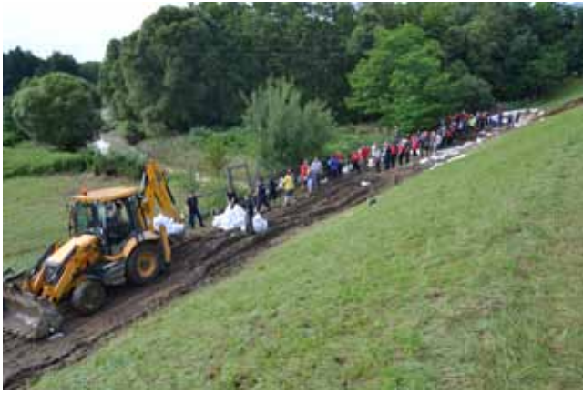
A VADÁSA TÓRENDSZERT ELVÁLASZTÓ VÉDMŰ SUVADÁSA UTÁNI MEGERŐSÍTŐ MUNKÁLATOK (FOTÓ: EGYED LÁSZLÓ TŰ. ALEZ.)
