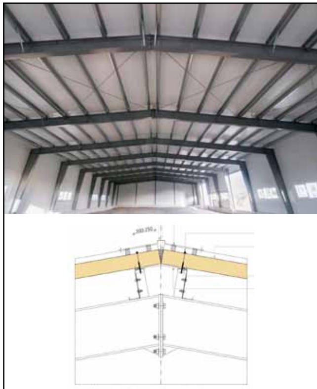
Z-SZELVÉNYŰ TETŐSZELEMEN ÁLTAL ALÁTÁMASZTOTT HŐSZIGETELT SZENDVICSPANEL
