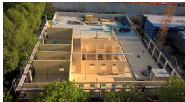
BÉCSI ISKOLAÉPÜLET FÁBÓL, KIVITELEZÉS KÖZBEN
