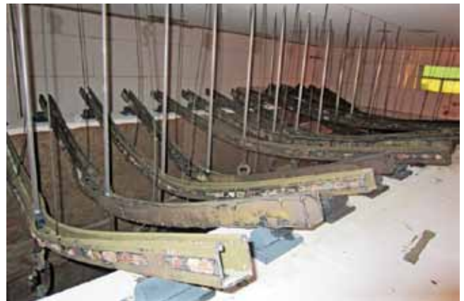
HŐ HATÁSRA DEFORMÁLÓDOTT TARTÓSZERKEZETEK
