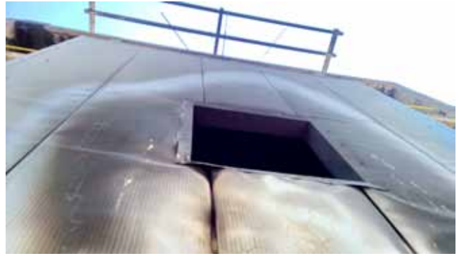
A FÜGGŐLEGES FAL A TŰZ UTÁN
