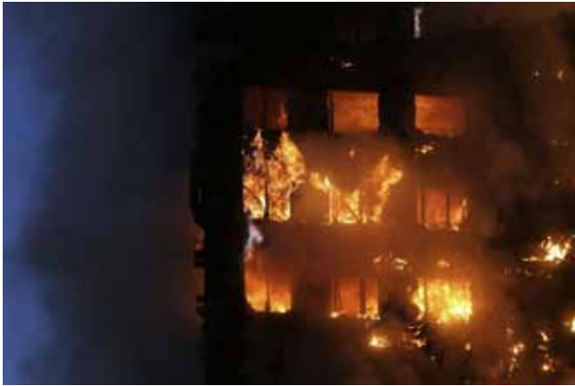
ÉGVE CSEPEG A HOMLOKZATBURKOLAT
