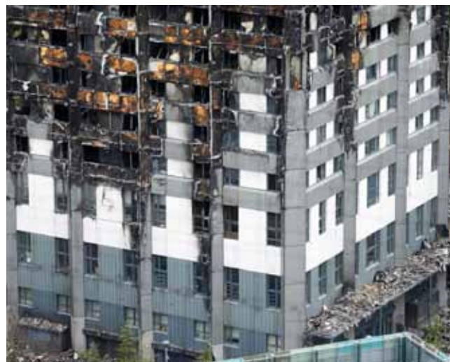
GRENFELL-TORONY: ÉGHETŐ ANYAGOK AZ ÁTSZELLŐZTETETT HOMLOKZATON
