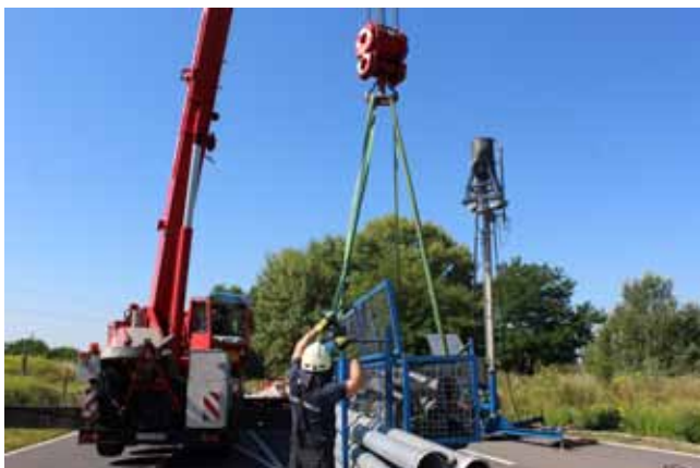
A HELYSZÍNI MEGSEMISÍTÉSHEZ SZÜKSÉGES RENDSZER ÖSSZEÁLLÍTÁSA
