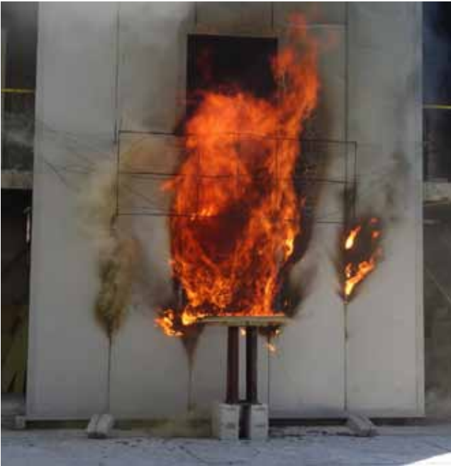
4. ÁBRA: AZ ÁLLÓ FALPANELES SZENDVICSPANEL HOMLOKZAT VIZSGÁLATA
