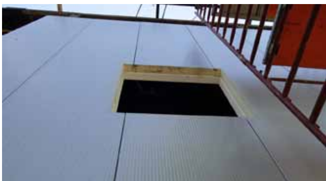
3. ÁBRA: AZ ÁLLÓ FALPANELES VIZSGÁLATI MODELL, ÉPÍTÉS KÖZBEN
