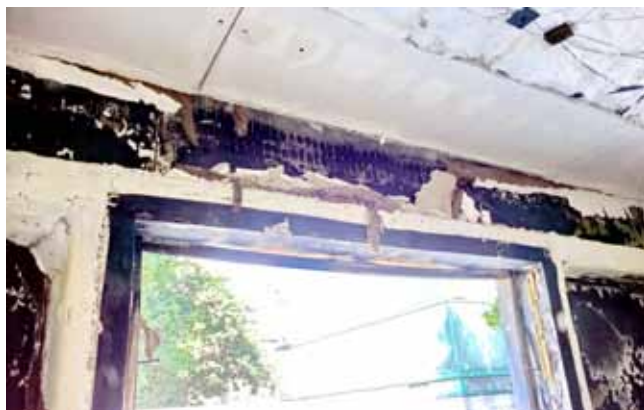
A TŰZTÉR FELETTI SZINT BELÜLRŐL
