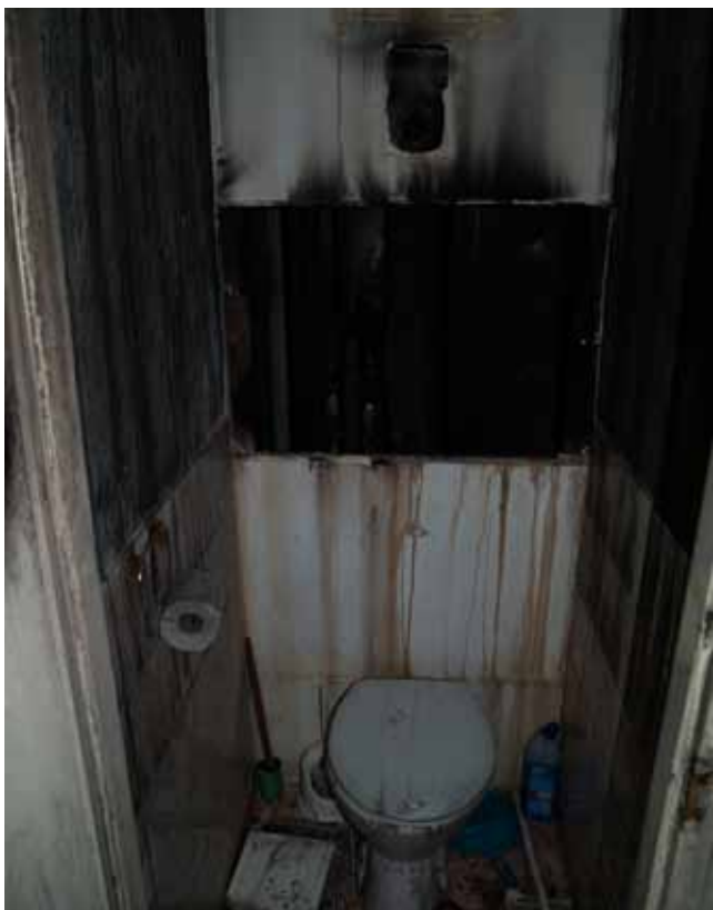
FÜSTTERJEDÉSI NYOMOK A GÉPÉSZETI AKNÁBAN
