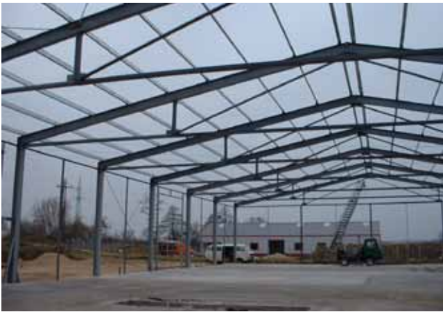
CSARNOK, ÉPÍTÉS KÖZBEN
