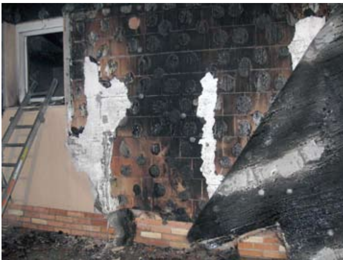
A falról leégett az éghető hőszigetelés
