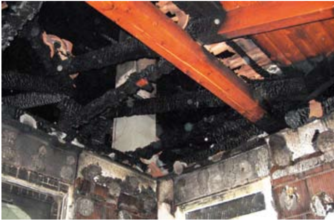
A padlás 20 cm éghető anyaggal volt hőszigetelve, egy zárlattól leégett a ház
