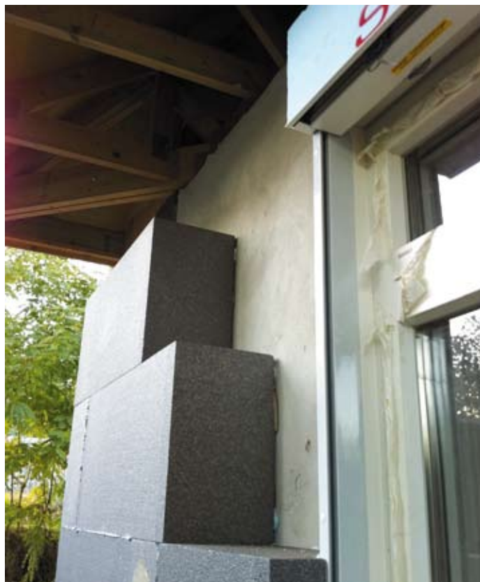
Mi lesz az eresznél? (A szigetelési síkoknak folytonosnak, befordulónak kell lenniük!)
