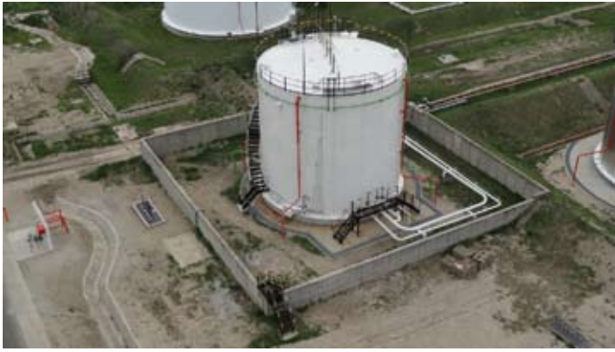
Beton védőfallal kialakított védőgödör (Fotó: FER Tűzoltóság)
