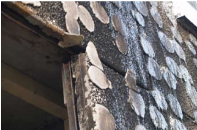
3 sz. kép. A Miskolc, Középszer u. 20 sz. alatti épület homlokzata a tűzeset után (a szerző felvétele)
