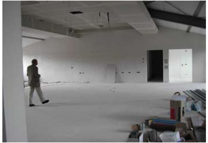
Építés alatt figyelemmel kísérni
