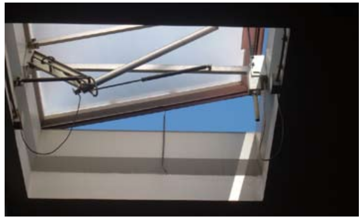
Pneumatikus munkahengeres kupola elektromos szellőztető motorral, szellőztető állapotban
