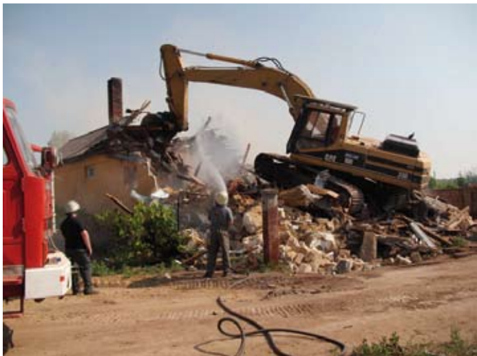
A megrongálódott épület bontása
