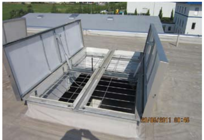
Dupla nyílászárnyas pneumatikus munkahengeres kupola RWA állapot
