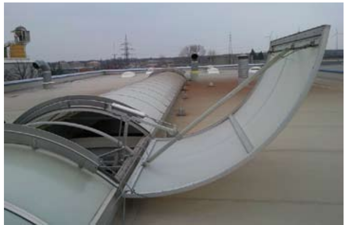
Sáv-felülvilágító nyílászárny kis szélterelővel, pneumatikus munkahengerrel, RWA állapot
