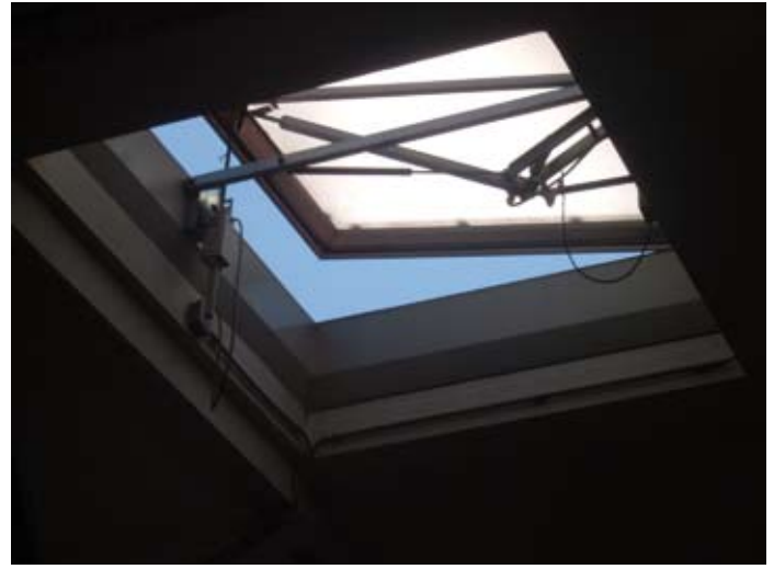
Munkahengeres kupola, motoros szellőztetés. Szellőztető állás
