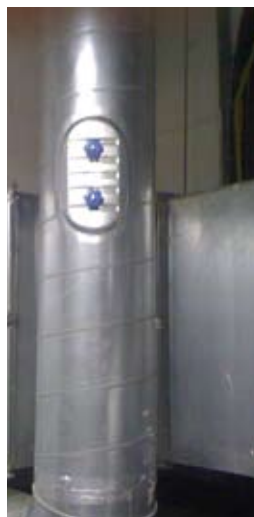
Tisztítónyílás a légtechnikai rendszerben
