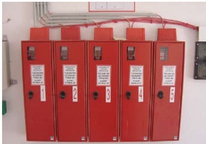
Kompakt megoldás, CO 2 -es vésznyításhoz. 18 db elég
