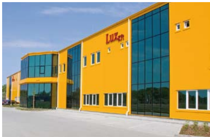
Lux Kft. gyártócsarnok, Kecskemét (Kivitelező: Fémszerkezet Kft, Nyíregyháza)
