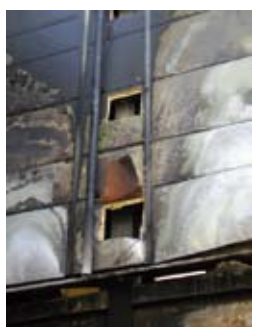
Tisztán látszik a hőszigetelő mag, mely a közvetlen, nyílt lánggal való érintkezés ellenére is gyakorlatilag sértetlen maradt.
