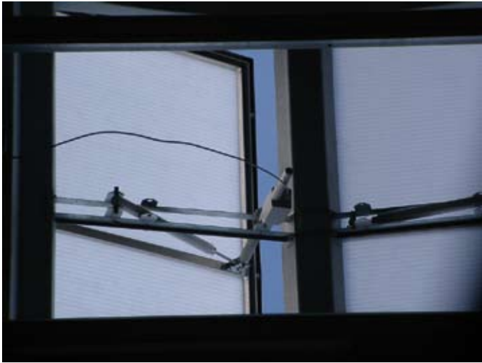
Dupla nyílászárnyas kupola, szellőztető állás (Munkahengeres RWA + motoros szellőztetés)
