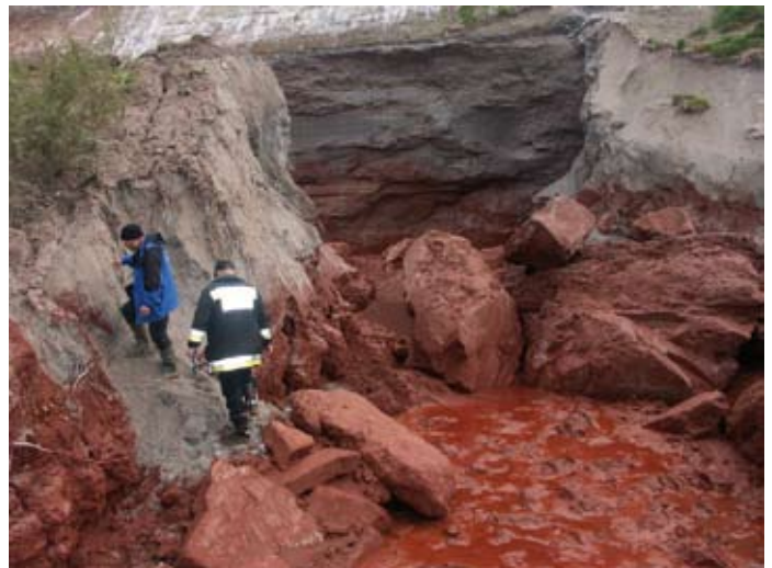
Hatalmas tömbök váltak le a gátról
