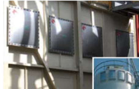
Lángelfojtó védelmi eszköz (Q-cső)
