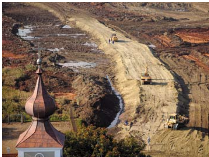
6. ábra. Védőtöltés építése (H. Szabó Sándor, MTI)
