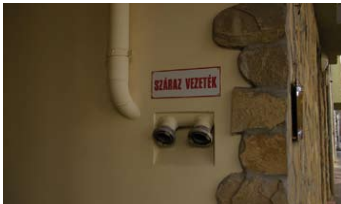
5. kép. Megkérdőjelezi a csatlakozás biztonságos végrehajtását
