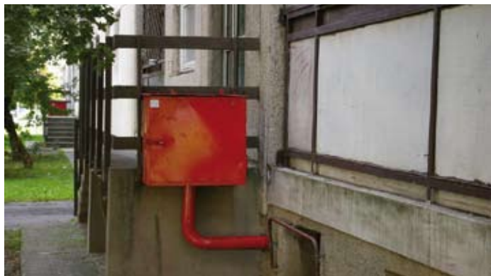
4. kép. Nem a tűzoltási felvonulási terület felől került kialakításra a száraz felszálló betáplálási helye
