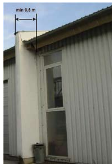
38. ábra. Tűzgát túlnyúlása a homlokzattól
