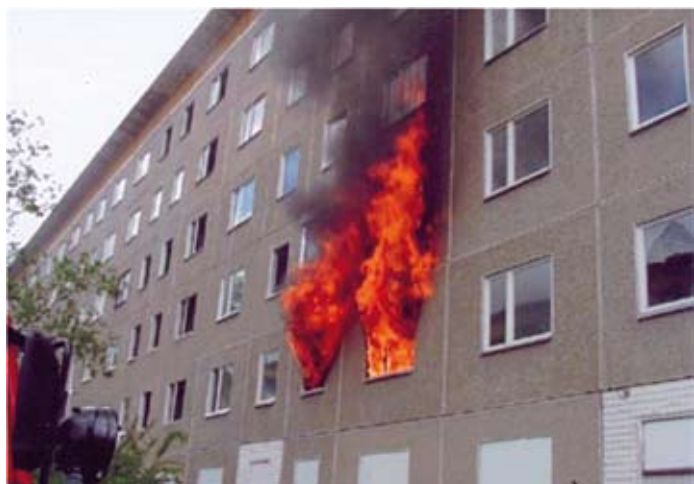
7-8 sz. képek. A hazai homlokzati tűzterjedési vizsgálóberendezés (épületléptékű, nyílásos homlokzati modell) és a homlokzati tűzterjedési vizsgálat igazolása tűzeseti képpel, A1 tűzvédelmi osztályú (azaz nem éghető) homlokzat esetén
