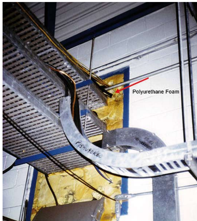
Poliuretán hab szigetelés az USA atomerőműben
