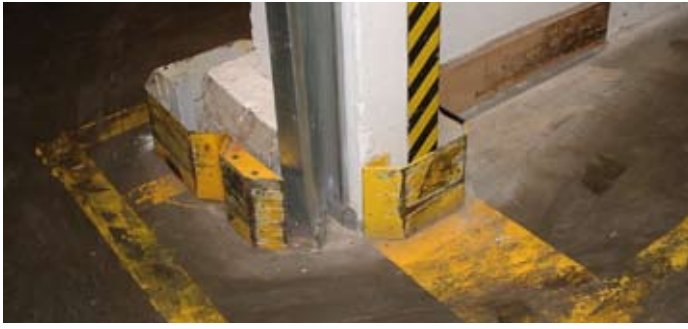
3 sz. kép. Tűzgátló tolókapu mechanikai védelmének hibája: a túl közel beépített védelem is sérült, nemcsak a kapu tokja – így nem csukódik megfelelően a kapu
