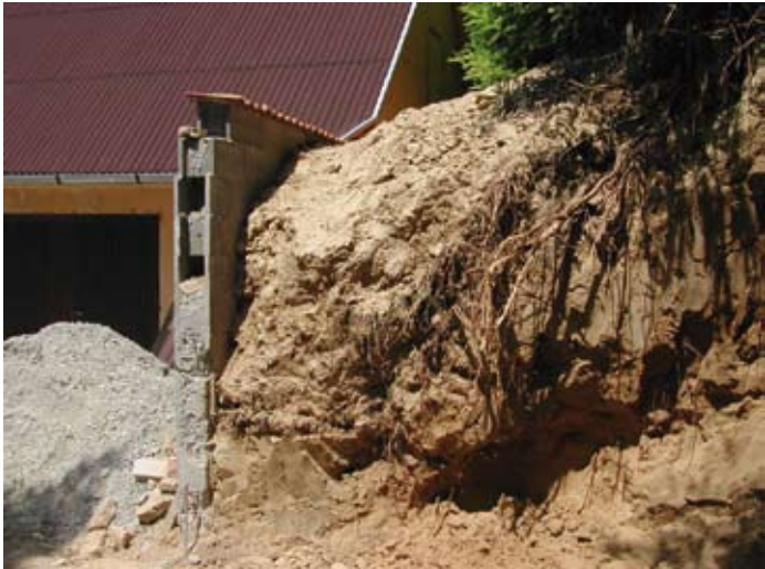
Kaposváron halálos áldozatot követelt a szabálytalan partfalbontás
