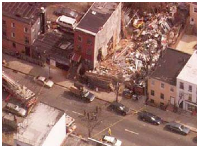
Épületomlás zártsorú beépítésben, épülettűz következtében (USA)
