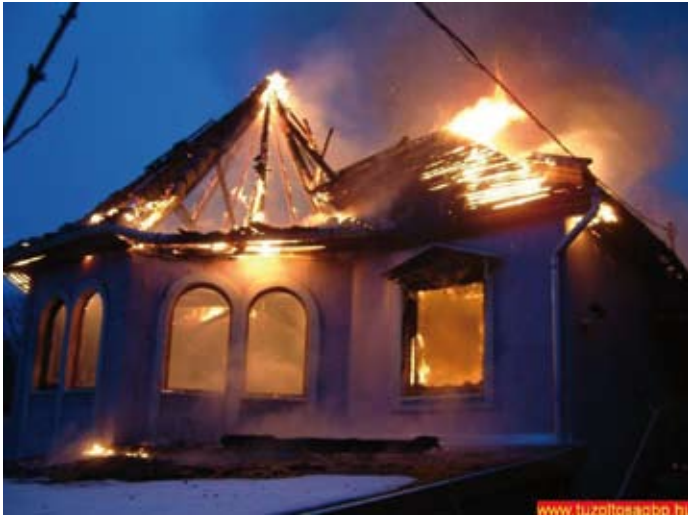
1 sz. kép. Fedélszék károsodása
