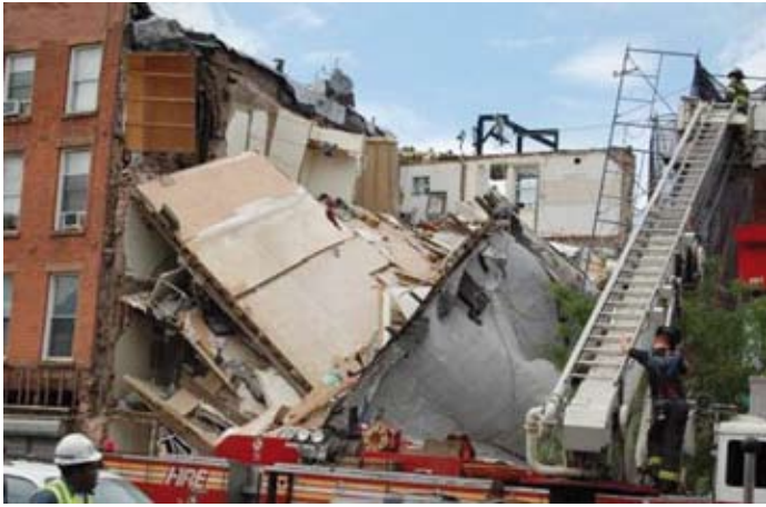
Épületomlás szakszerűtlen kivitelezési munka miatt, a szomszédos épület károsításával (USA)
