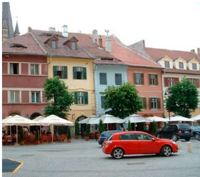
Tűzfal tetőszinti tűzterjedés elleni gáttal középkori városszerkezetben (Nagyszeben)
