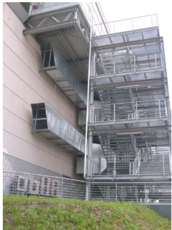
2 sz. kép. Statikailag épülettől független teherhordású szabadtéri menekülési lépcső
