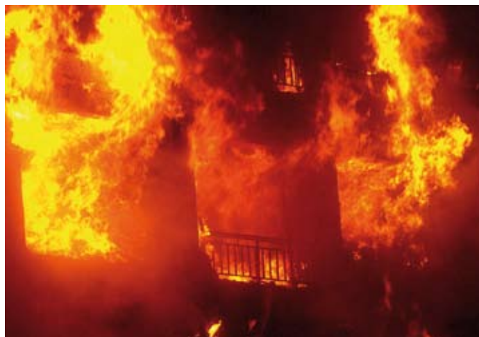
Hőszigetelő ég a homlokzaton
