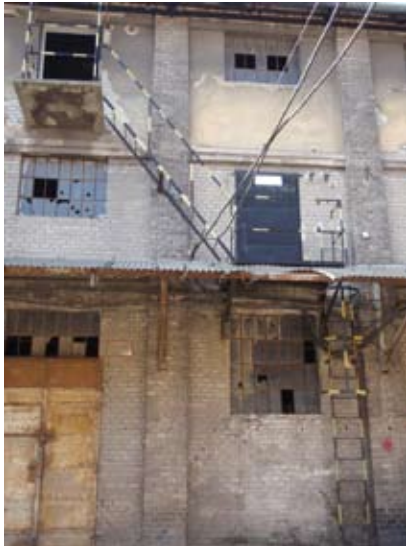
3 sz. kép. Épülethez rögzített szabadtéri menekülési lépcső
