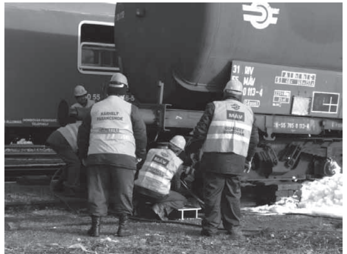
A MÁV szakemberei sínre teszik a kisiklott vagont
