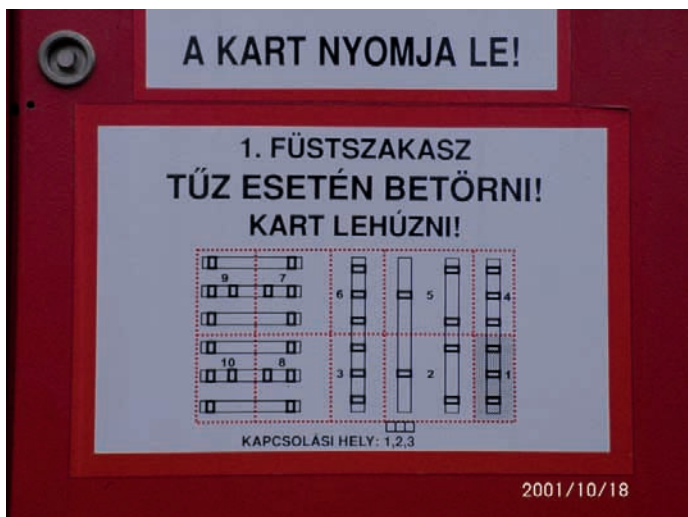
Tűzjelző jelére és kézi nyitásra működő CO 2 -es vésznyitó
