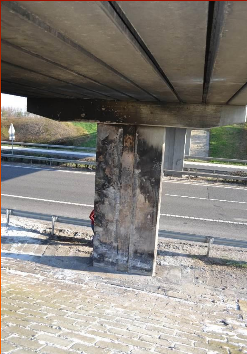
A hídpillér állapota a tüzeset után
