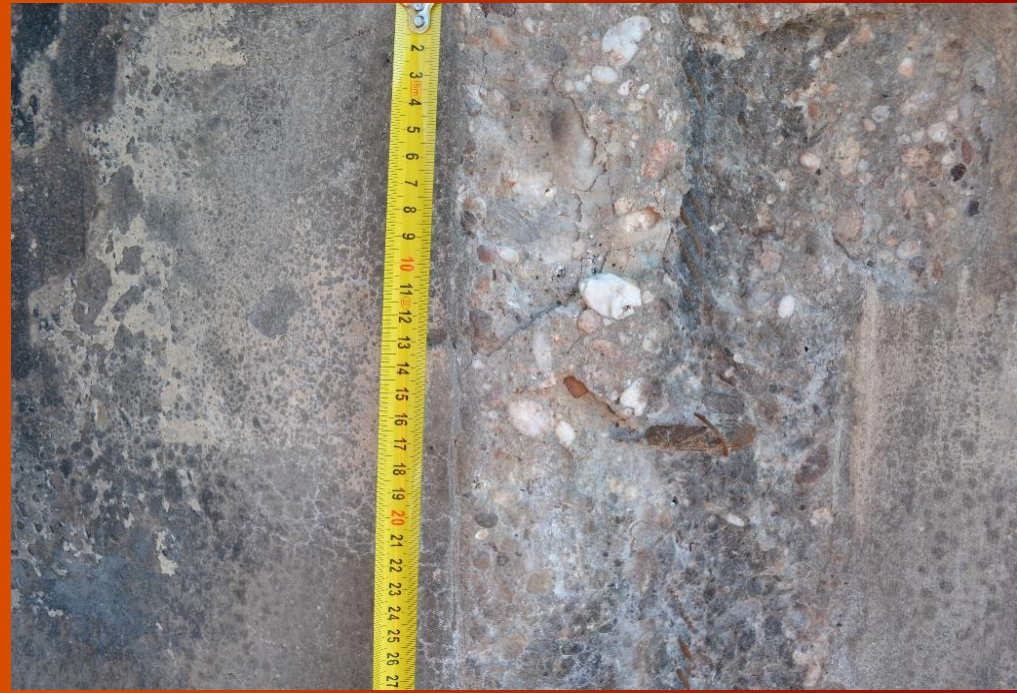
A beton károsodása a tűz eset után
