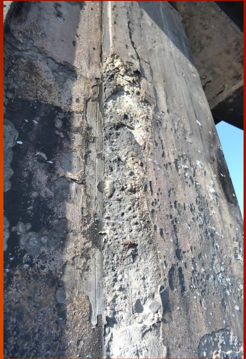
A hídpillér állapota a tüzeset után
