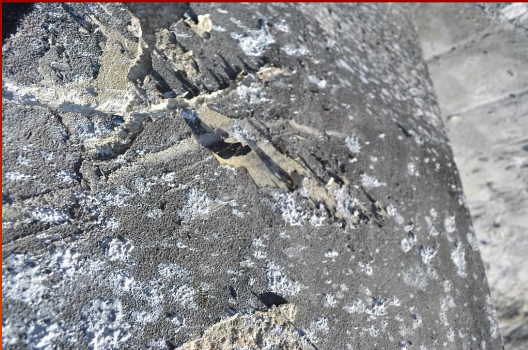
A műanyagbevonat károsodása
