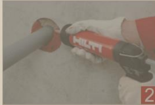
Gépészeti csőátvezetések Éghető csövek
