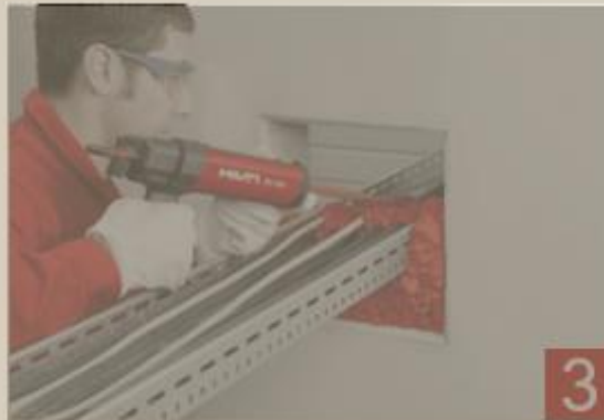
Kábel, kábeltálca átvezetések Kábeltálcák
