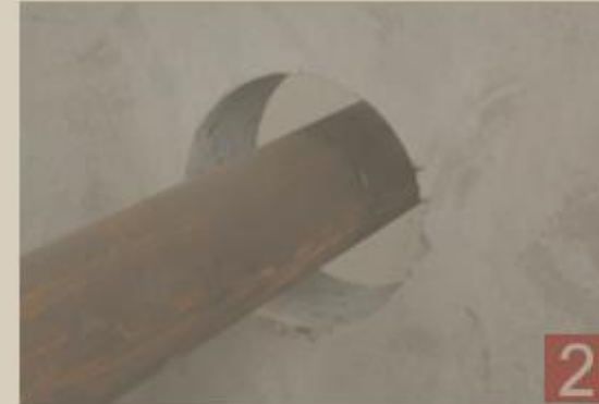
Gépészeti csőátvezetések Nem-éghető csövek
