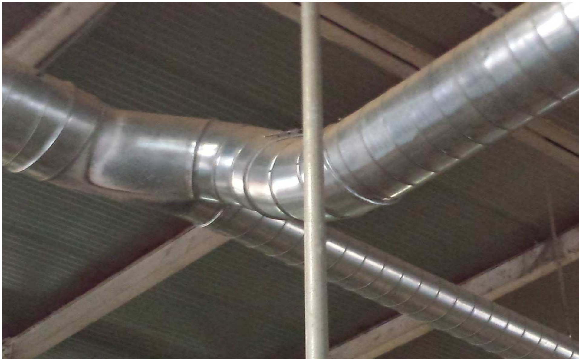
Porelszívó rendszer helytelen kialakítása
