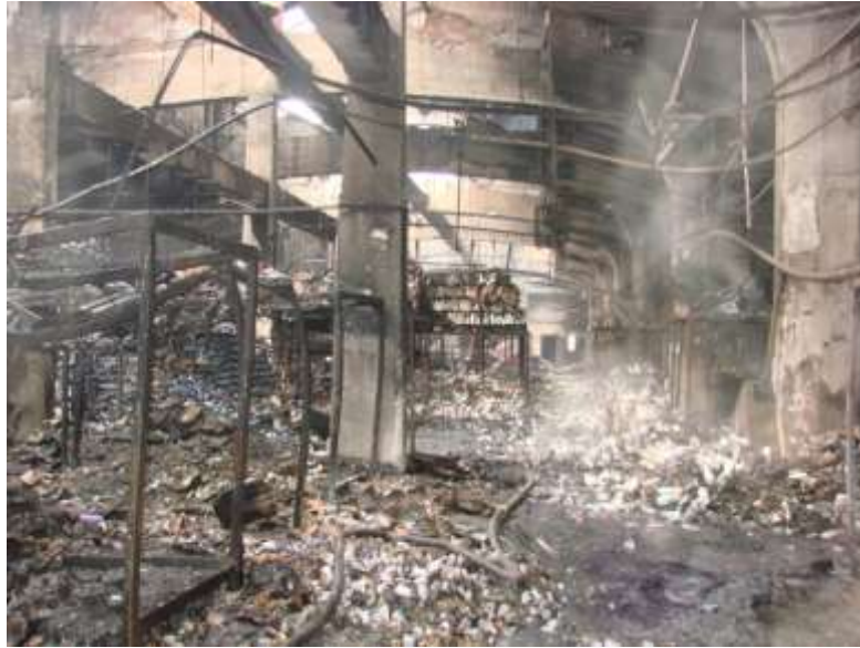
4. ábra: Kozmetikai termékek raktárépületében keletkezett tűz helyszíne, 2009 Forrás: FKI Tűzoltósági Főfelügyelőség
