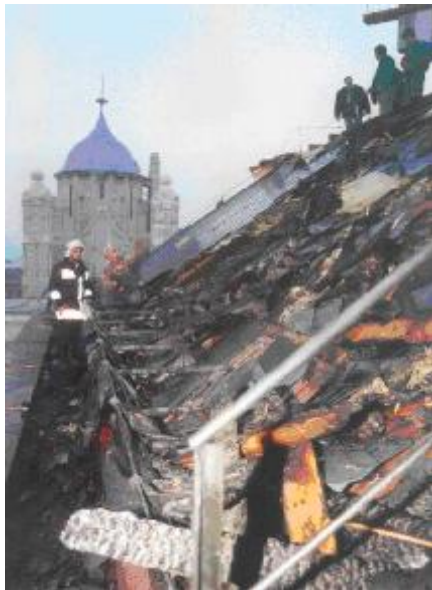
A károsodott tetőszerkezet
