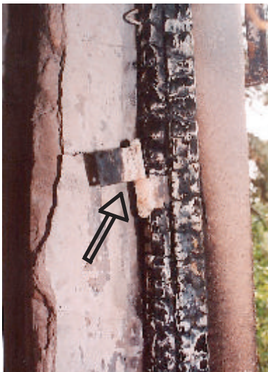
A mozdíthatatlan zsanér helyzetén látható, hogy az ajtó a tűz előtt nyitott állapotban volt
