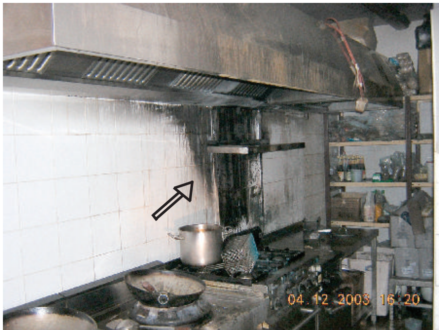
A falhoz közel keletkezett tűz „V” alakú nyomot hagyott a falon
