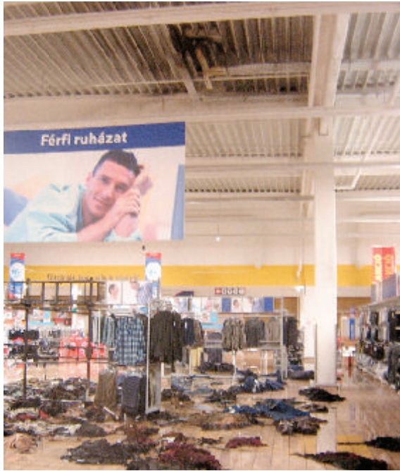
A tűz a mennyezeten kör alakú nyomot eredményezett A kör alakú nyom középponti vonalában keressük a tűz keletkezési helyét
