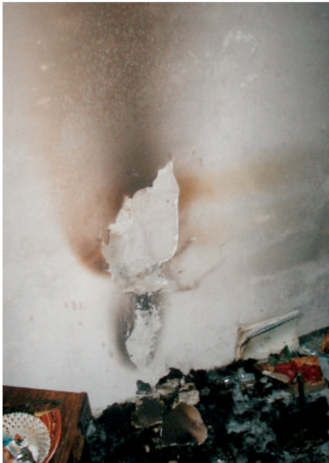
Korom lerakódás a falon
