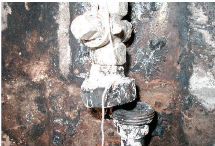
Megbontott állapotú gázvezeték
