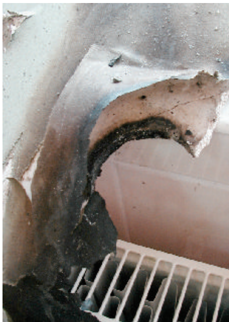
A tűz a gipszkartonba szerelt spotlámpa túlmelegedése következtében keletkezett
