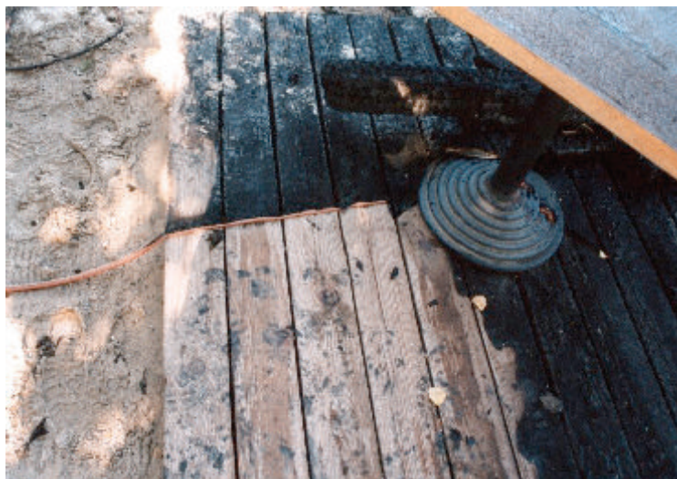
Égésnyomok. Jól láthatóak az éghető folyadék folyási, beszívódási határai.
