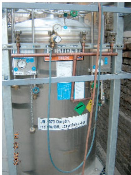
A lángvágó berendezés oxigén tartálya
