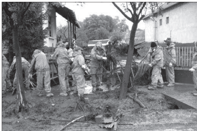
7. ábra. Helyreállítási munkálatok Kolontáron. (Forrás: Muhoray Árpád: Helyreállítási munkálatok Kolontáron. A szerző magángyűjteménye.)
