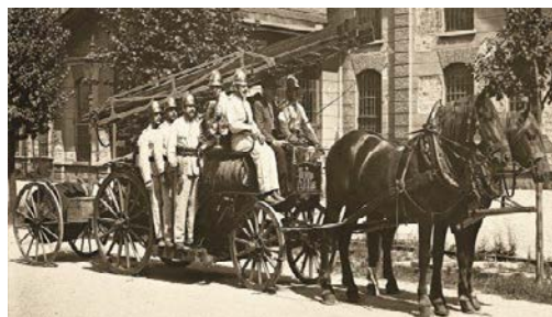
4. ábra: Rosenbauer gyártmányú belső égésű motorral hajtott, lóvontatású kocsifecskendő 1910-ből. Forrás: http://www.rosenbauer.com
