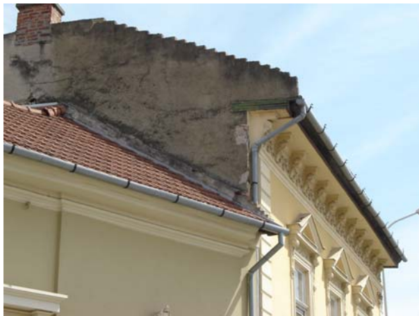
1. kép Tűzterjedés elleni gát és párkány védelem vakolattal Egerben
