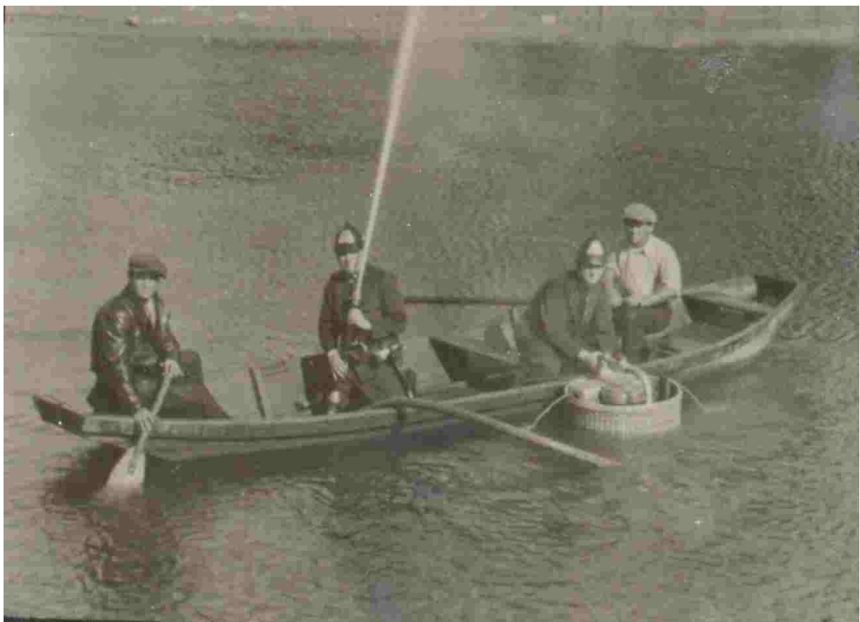
8. kép. Úszószivattyú munka közben
