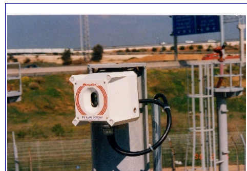
23. ábra: Tartályvédelemre alkalmazott tripla-IR lángérzékelő
