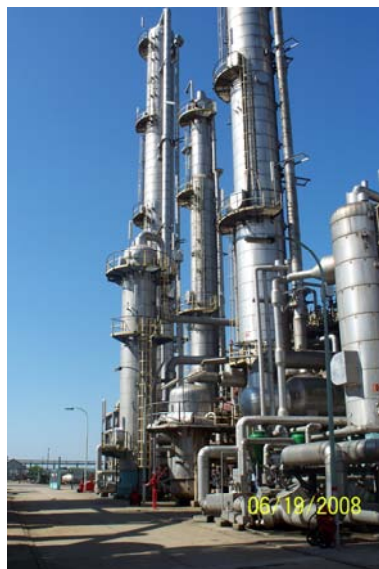
4. kép A 31-es rendszer (etán, etilén kolonna) (a szerző saját felvétele)
