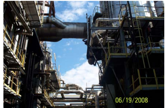
3. kép A kemencesort elhagyó pirogáz-vezeték (a szerző saját felvétele)
