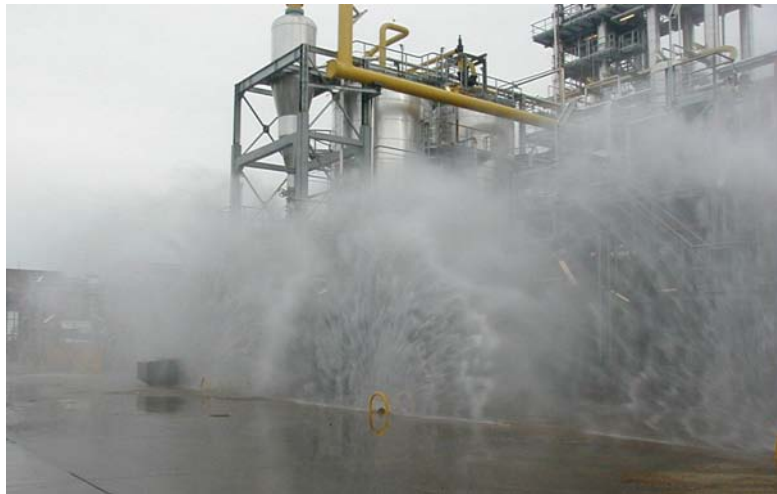
14. kép Beépített vízfüggöny ipari környezetben
