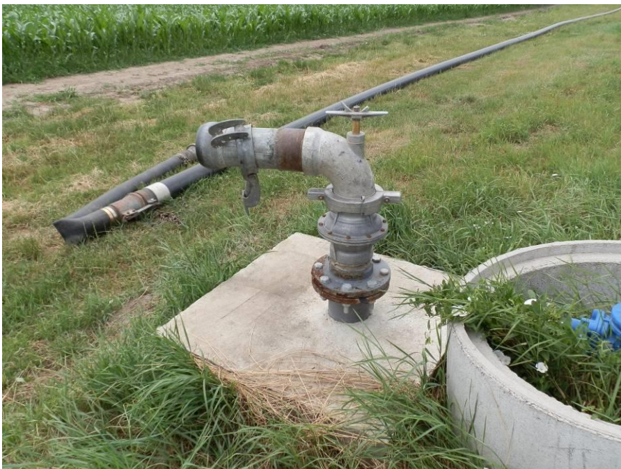
– Az öntözővíz hálózatra kiépített hidrások (forrás: Szerző felvétele)
