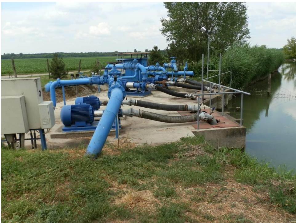
– Az öntözőrendszer vízellátását biztosító szivattyútelep (Forrás: Szerző felvétele)
