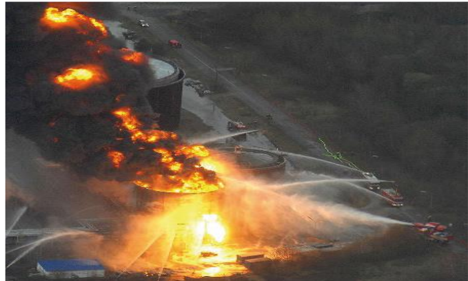
1. sz. ábra: Közreműködés tartály és védögödör tüzek oltásában, szomszédos tartályok hűtésében, [7]
