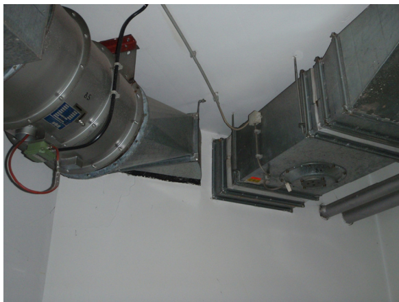
27. ábra Szellőző-, klímavezeték lezárása
